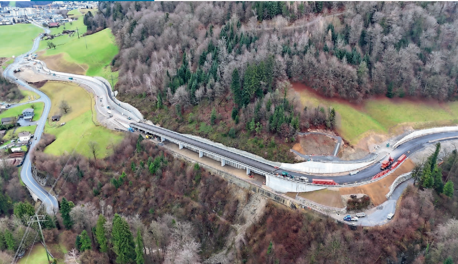
Der Strassenabschnitt des Rängglochs wurde umfassend saniert. Bilder: zvg
