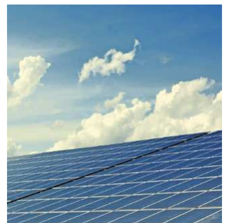
Mit dem neuen Energiegesetz sollen PV-Anlagen auf Dächern gefördert werden. Bild: Pixabay
