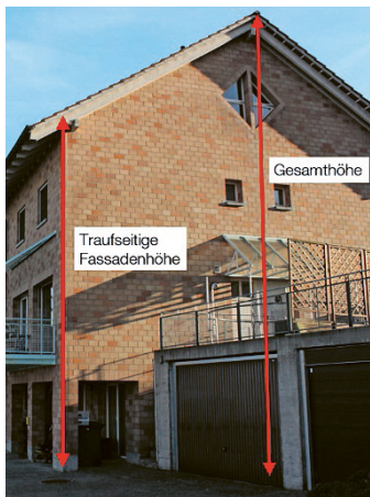
Abb. 1 Gesamthöhe: Grundwert + Zuschlag für Schrägdach
