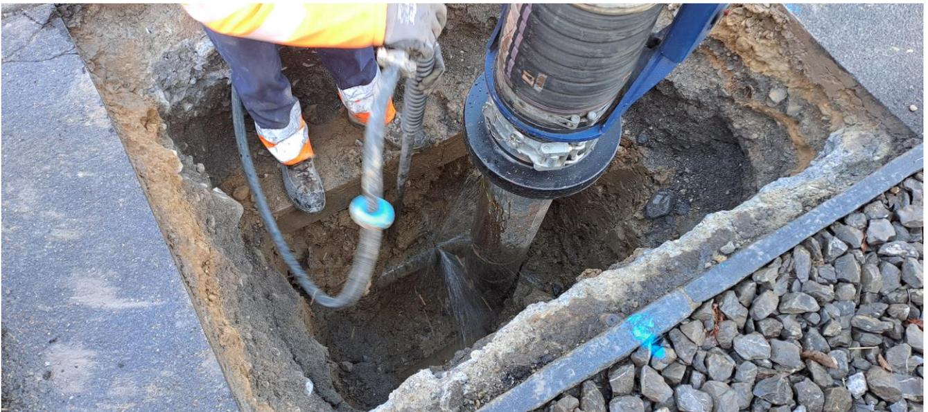
Mit den heutigen Geräten können Leckstellen meistens sehr genau geortet werden (blaue Markierung). Mit Hilfe eines Saugbaggers kann die Leckstelle innert kürzester Zeit auf einer kleinen Fläche zur Reparatur freigelegt werden, ohne dass dabei benachbarte Leitungen oder Wurzelwerk von Bäumen beschädigt werden.
