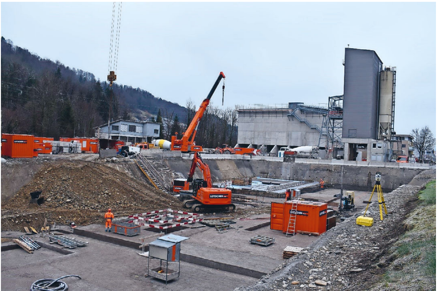
Baustelle beim Betonwerk
