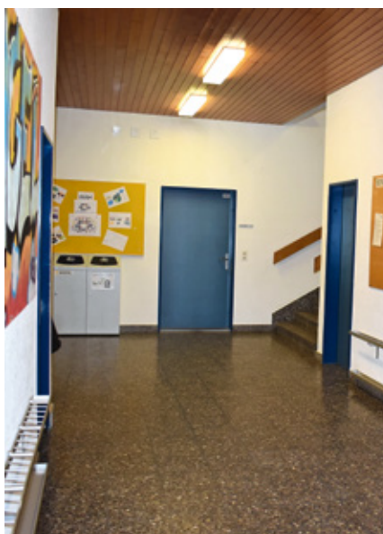
Der grösste Investitionsbrocken: das Schulhaus Muoshof, hier mit dem Trakt 3, der abgerissen wird. Bild: swe
