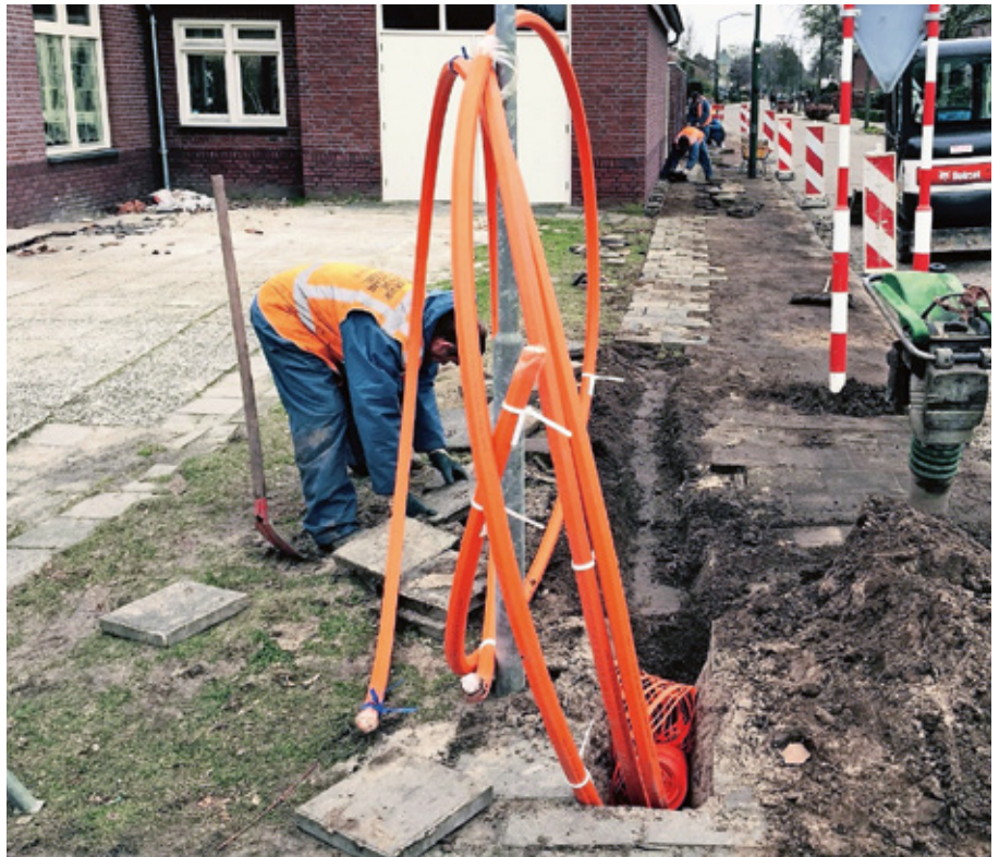
Ab Winter 2023/24 werden die Glasfaserkabel verlegt. Symbolbild: Pixabay
