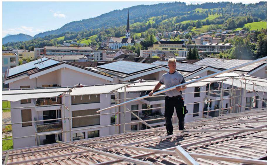
Die Arbeiten auf dem Dach, ausgeführt durch die Firma Bühlmann Bedachungen, sind weit fortgeschritten. Im Hintergrund der bereits sanierte Bau mitsamt PV-Anlage Oberfeld 9+11. Bild: zvg
