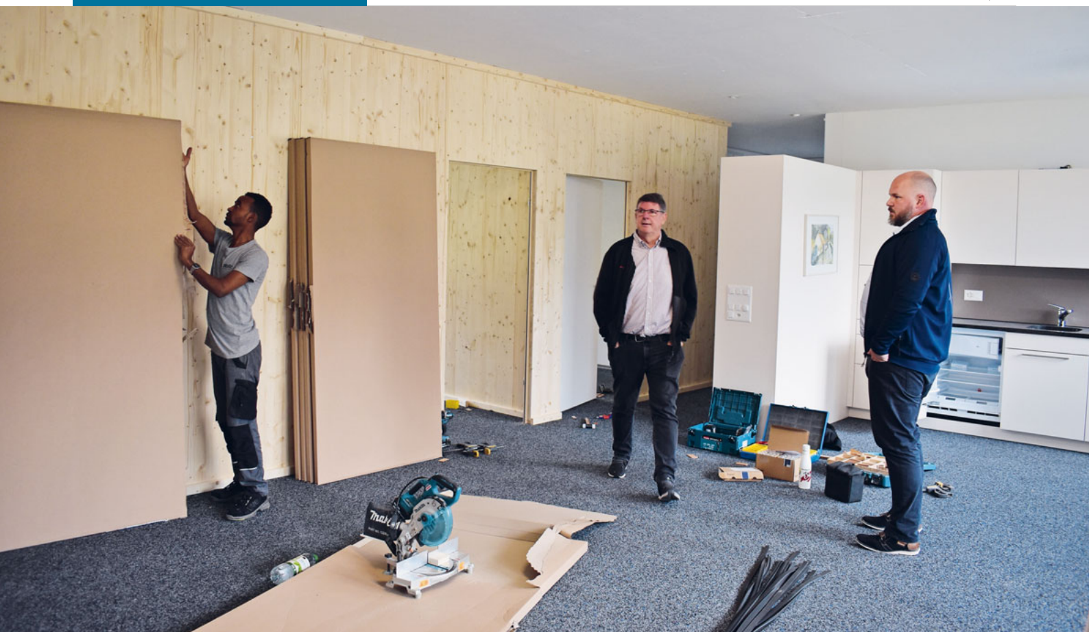
Mittlerweile ist die Unterkunft Im Feld fertig eingerichtet. Nächstens ziehen die Schutzsuchenden ein. Bild: Stephan Weber
