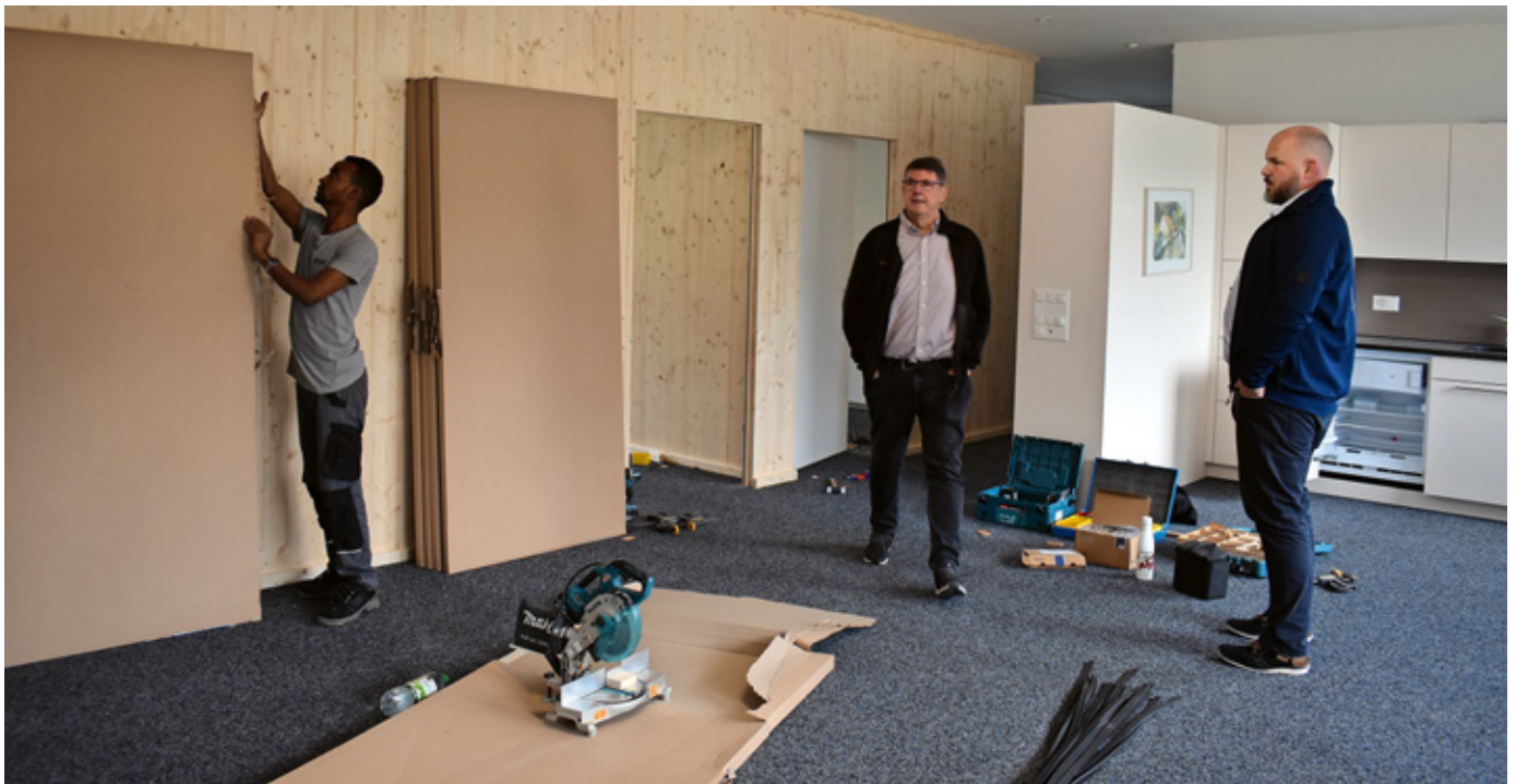
Am 10. Mai: Die Zimmer in der Unterkunft Im Feld werden eingerichtet. Bild: Stephan Weber
