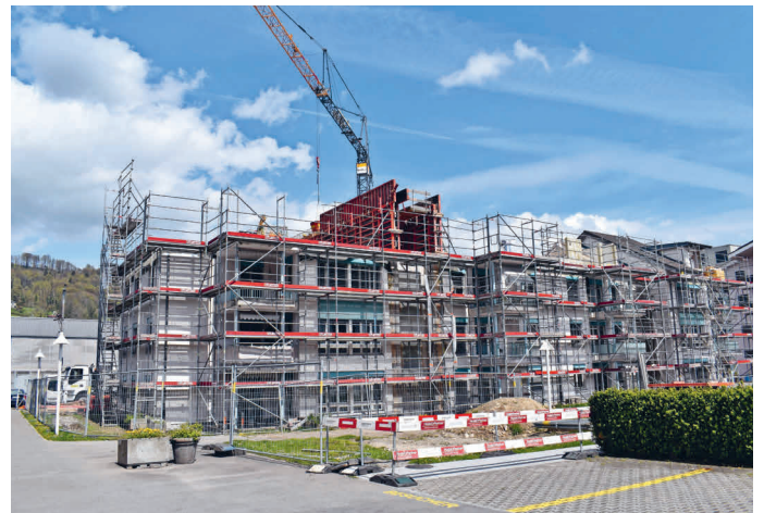
Aufstockung im Oberfeld
