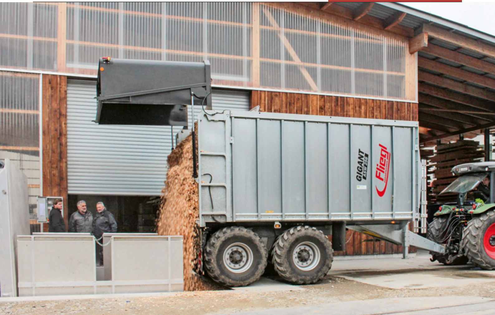
Erste Befüllung des rund 420 Kubikmeter umfassenden Brennstofflagers mit Hack-schnitzeln aus der Region Malters und Umgebung. Bilder: Walter Weibel
