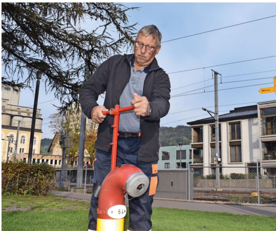
Die Kontrolle der Hydranten: Das gehörte zu Toni Buchers Arbeitsalltag.
