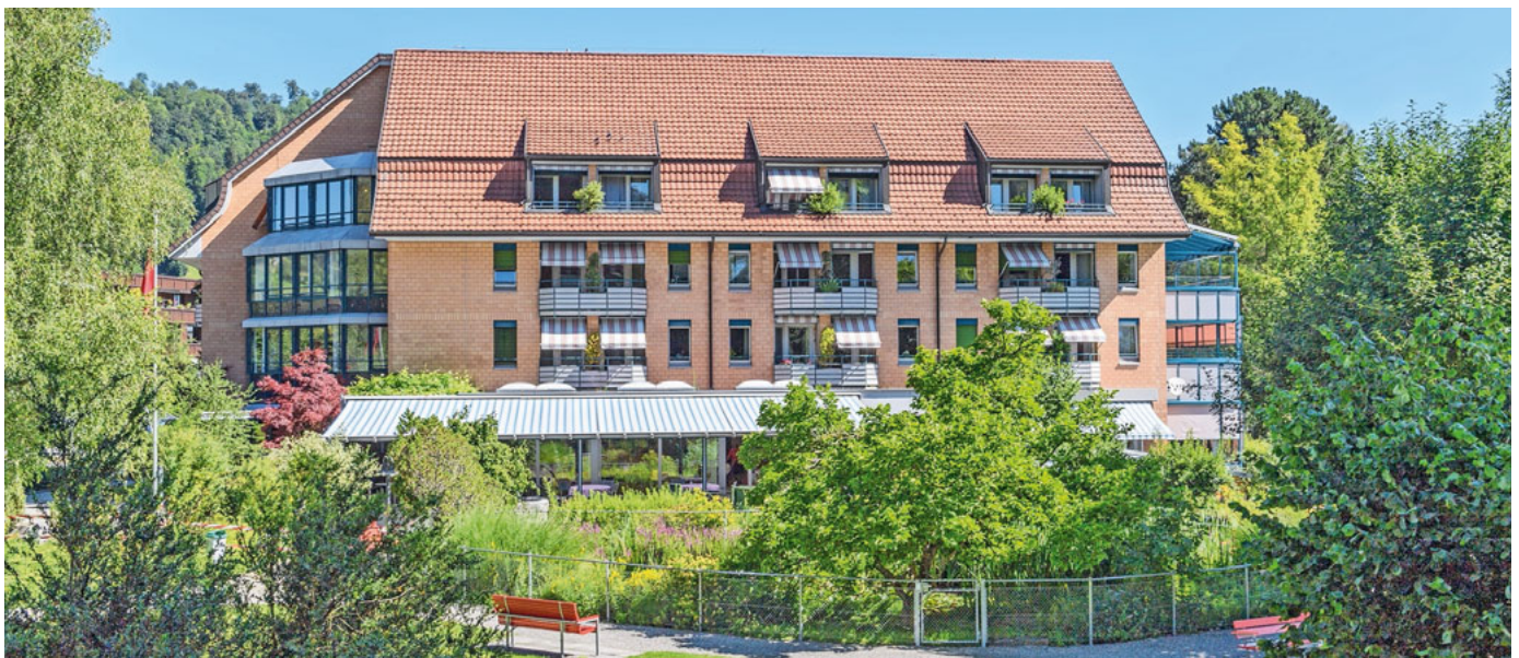
Das Alters- und Pflegeheim Bodenmatt von aussen.
