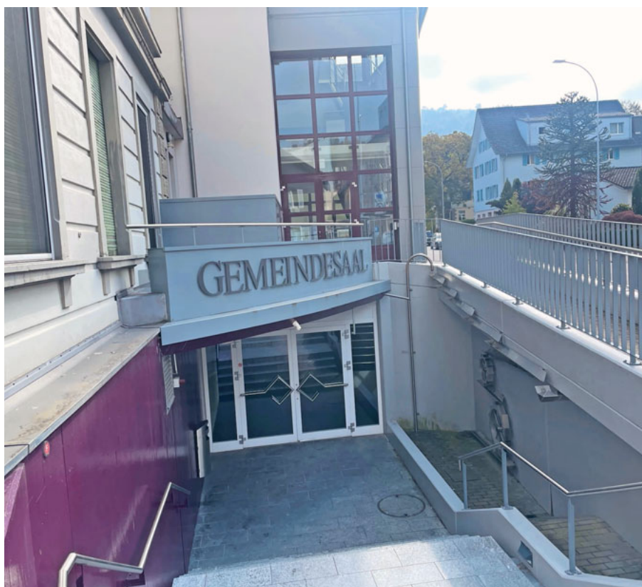
Im Gemeindesaal soll 2023 der Lift ersetzt werden.
