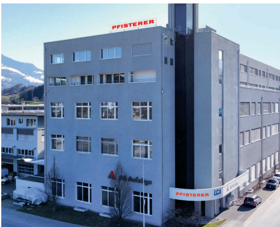
Der neue zentrale Firmensitz der Pfisterer Switzerland AG in Küssnacht am Rigi.
