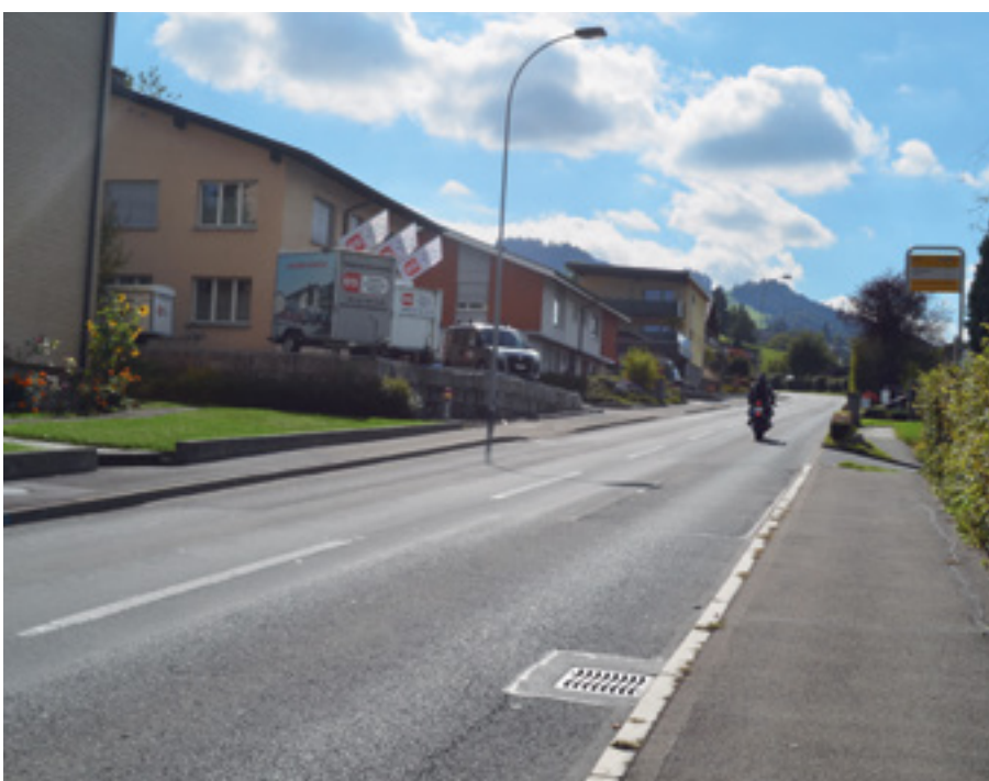
Der Kanton will die Schwarzenbergstrasse (Bild) sanieren, die Gemeinde plant Investitionen in die Leitungsbauten von der Luegetenstrasse bis zum Klösterliweiher.
