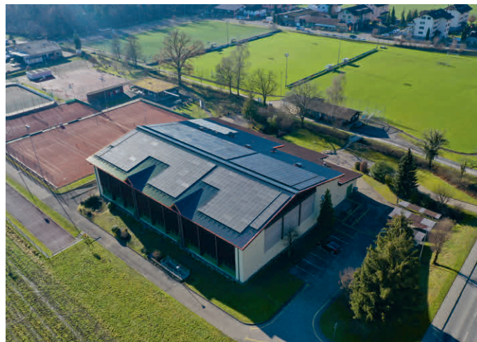
Photovoltaik-Anlage Sporthalle Oberei
