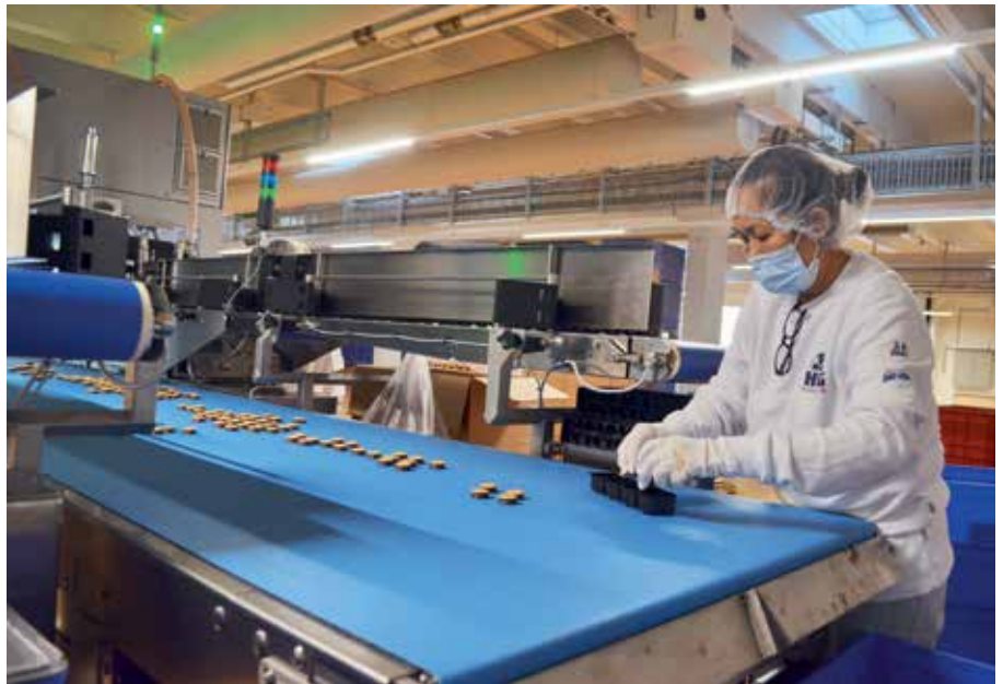
Mehrere 100 Meter neue Förderstrecken wurden im «backhaus» eingebaut.
