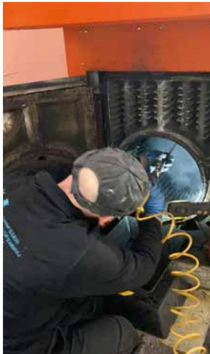
Beim Reinigen der Ölheizung
