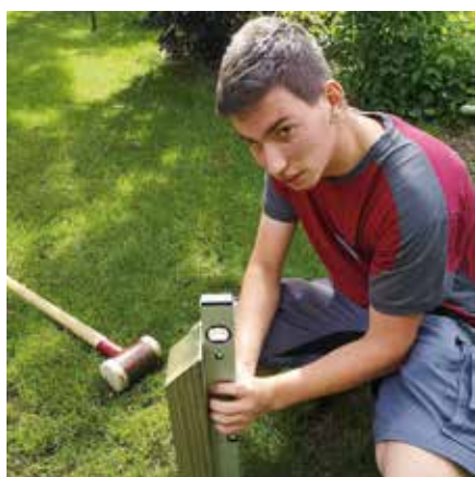
Ausrichten des Holzpfahls
