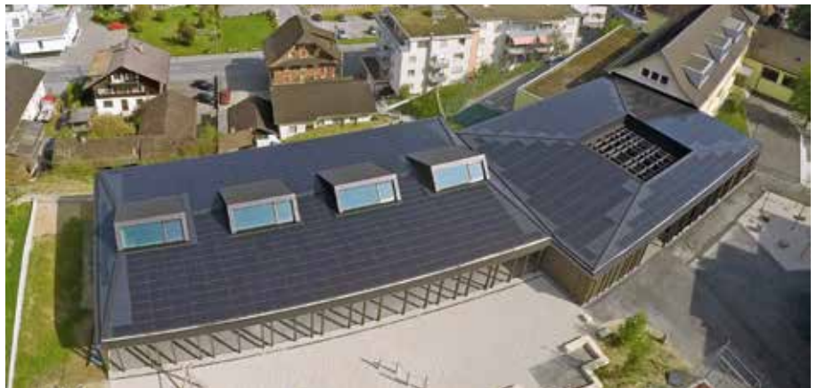
Fotovoltaikanlage auf dem Dach des Schulhauses Bündtmättli
