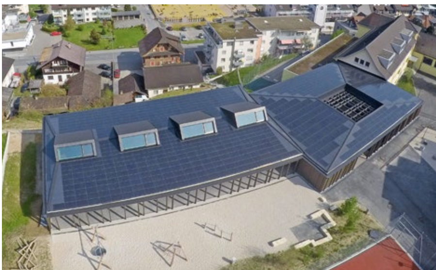
Fotovoltaikanlage beim Schulhaus Bündtmättli
