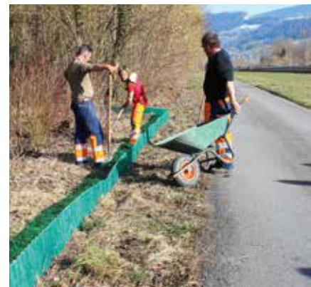
Mitarbeiter des Werkdienstes beim Bau des Schutzzauns
