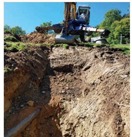
Im steilen Gelände wird die Zielgrube erstellt
