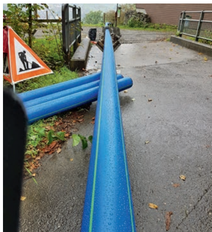
Der Rohrstrang wird vorgängig aus einzelnen Rohren zusammengeschweisst
