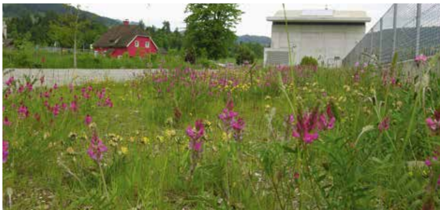
Naturwiese beim Kraftwerk im Ettisbühl
