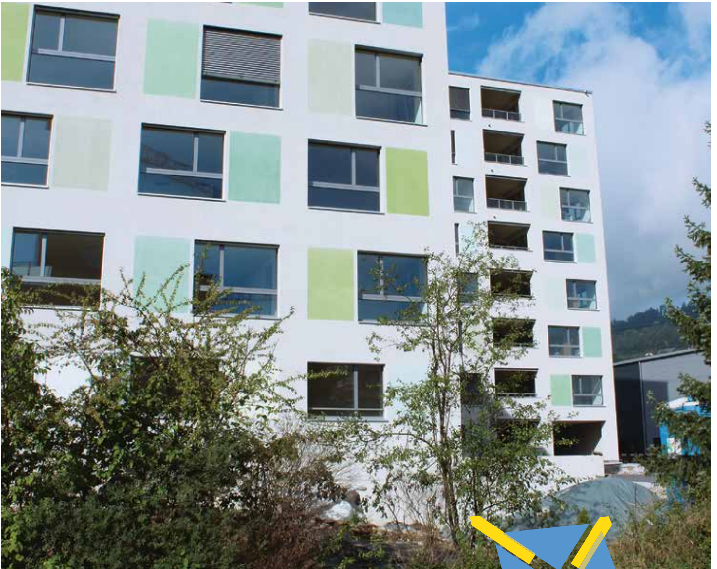
Die Zentrumsüberbauung «Malters Höfe» nimmt Gestalt an.
