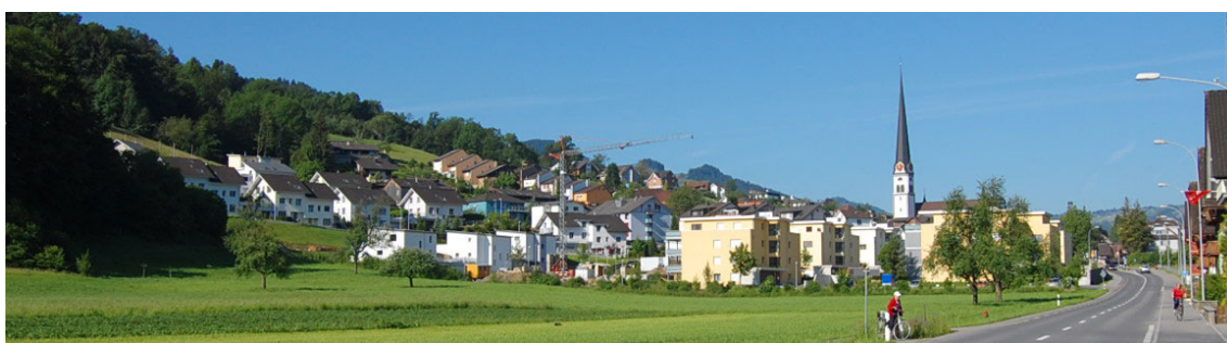
Abb. 3: Östlicher Dorfeingang, Luzernstrasse. Links im Bild die neuen Überbauungen Chällerhof und Ober Chällerhof
