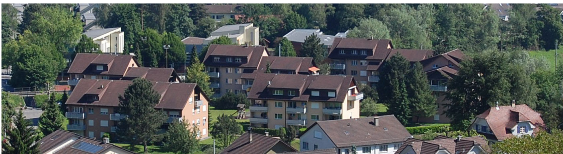
Abb. 5: Viergeschossige Wohnzone Muoshof
